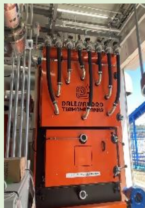
バイオマス温水ボイラー 300kW
