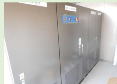
バイオマス温水ボイラー 300kW
